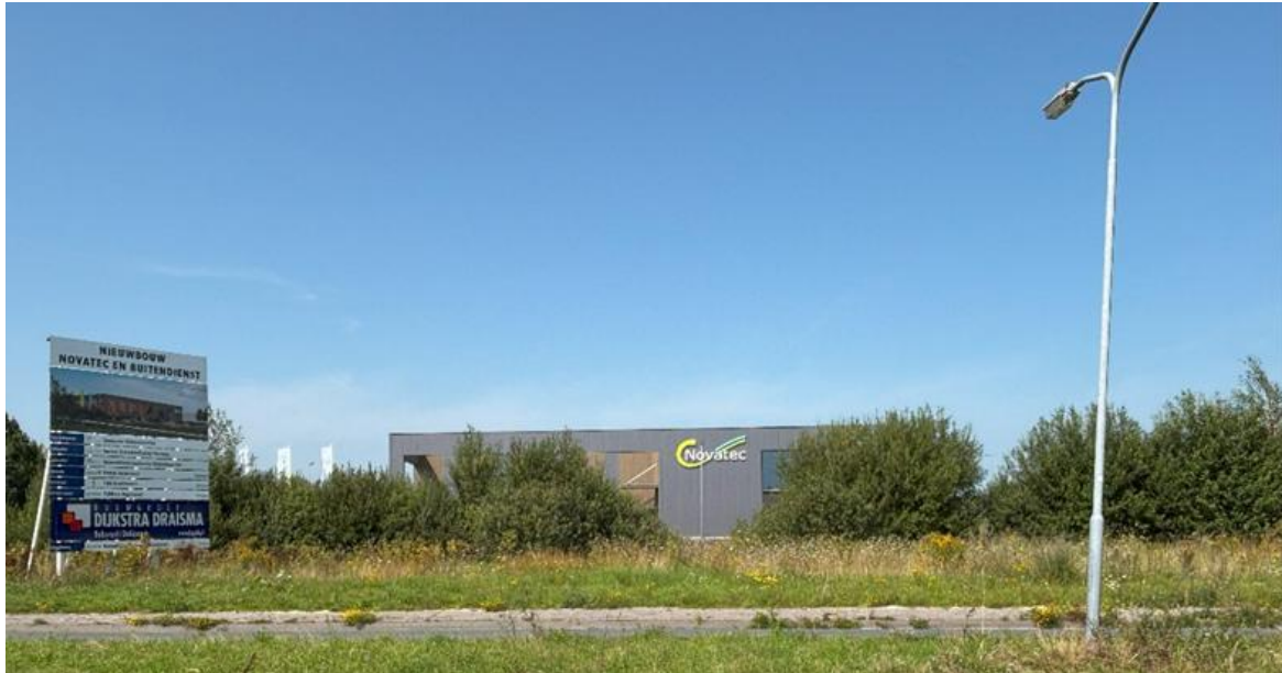
Het nieuwe gebouw van het gemeentelijke werkbedrijf Novatec in Leek. foto: AV
